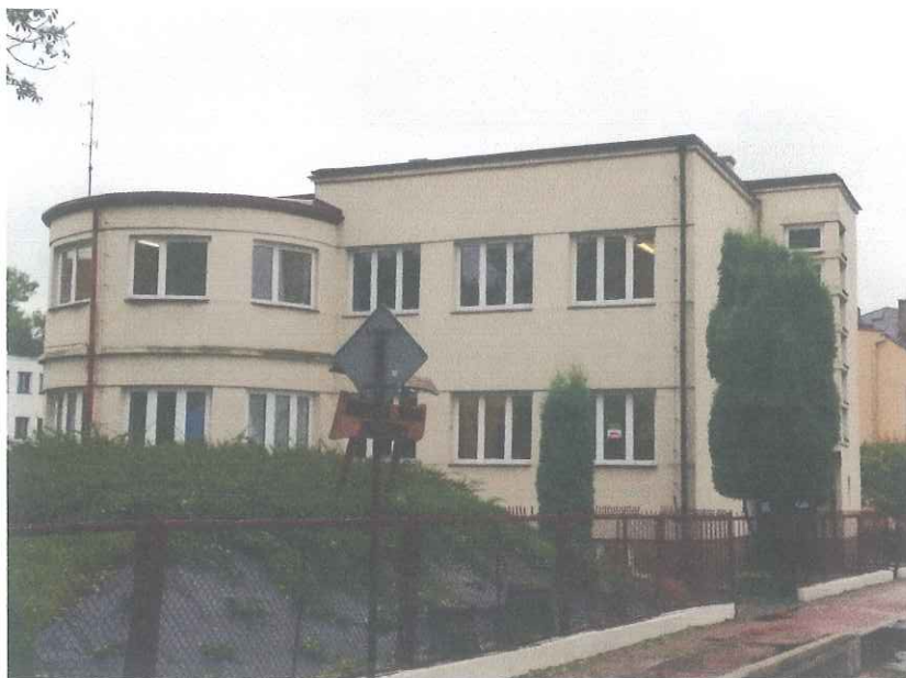
fot. 1. Elewacja wschodnia
