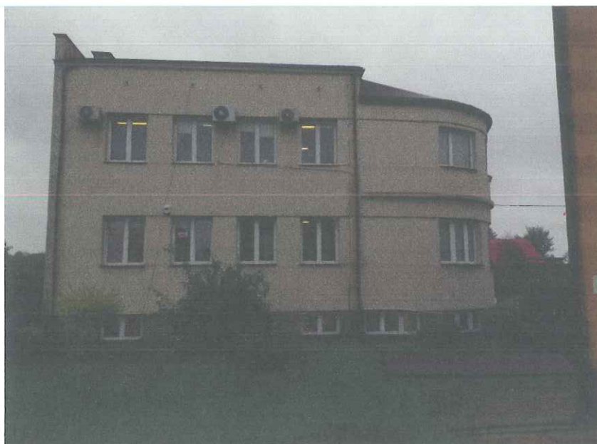
fot. 2. Elewacja południowa
